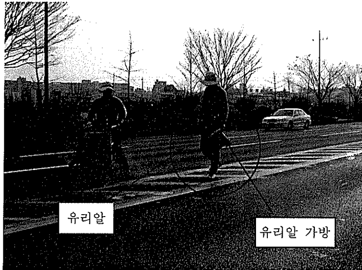
[그림 3-15] 노면표시 시공시 유리알을 손으로 뿌리는 모습
