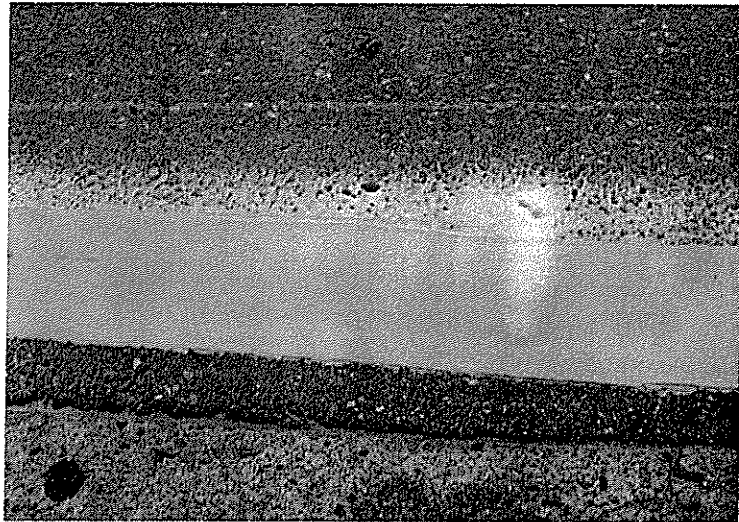
[그림 3-14] 시공결과 도료와 유리알이 정확하게 부착되지 못한 모습
