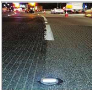
8. 표지병 설치 후2
