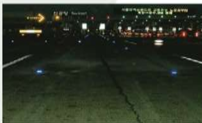
서해대교 하이패스구간 설치
